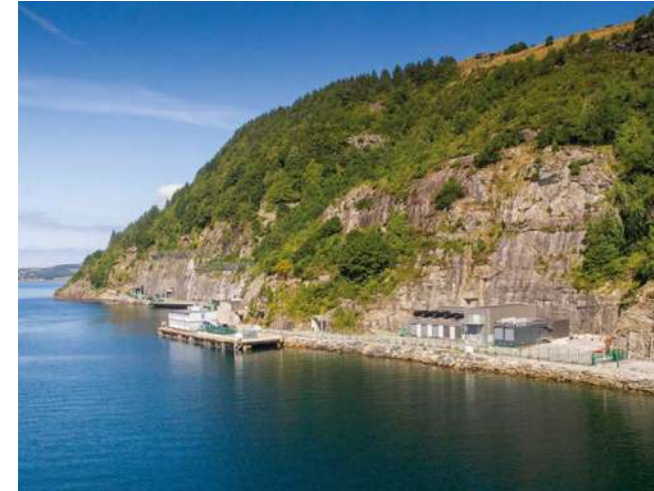
SITE DE GREEN MOUNTAIN À RENNESØY CRÉDITS : Green Mountain
