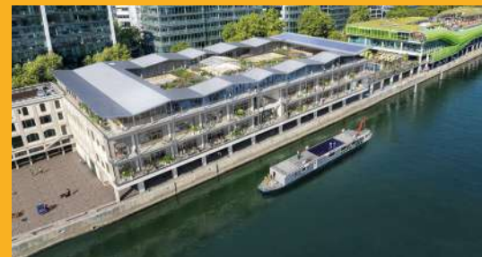
L'HÔTEL LOGISTIQUE FLUVIAL « LES AMARRES » (PARIS, 13 e ) incarne les ambitions du Groupe Sogaris pour la ville durable : multimodal, ouvert sur le territoire, tourné vers la mixité d'usages et solidaire. CRÉDITS : Encore Heureux et Metrochrome
